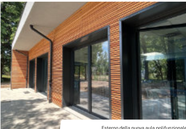
Esterno della nuova aula polifunzionale
